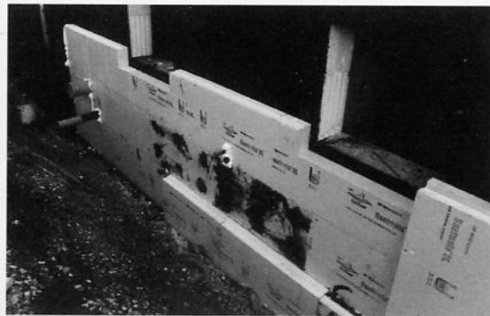
fig. 2-2 Mur extérieur de la cave avec joint d'étanchéité et isolation
