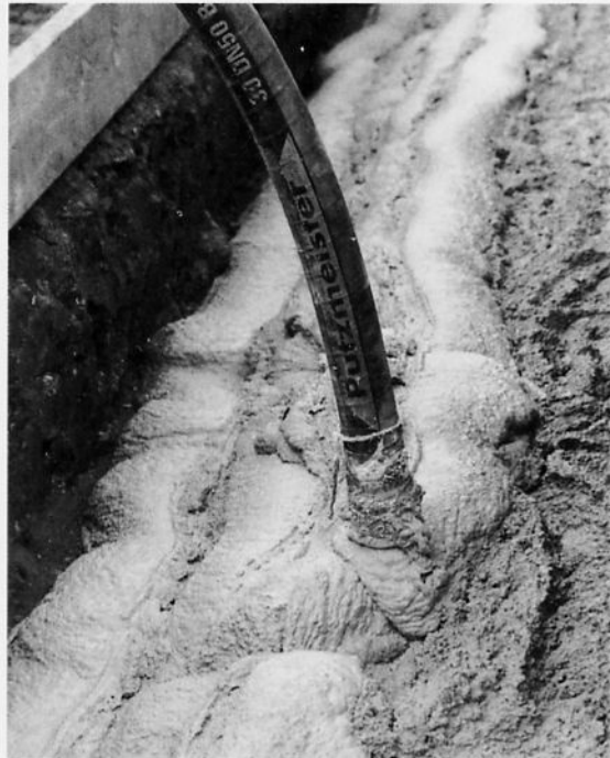
fig. 2-5 Béton cellulaire appliqué à l'aide d'une pompe à béton
