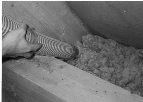
fig. 2-31 Photo de l'isolation du chevron
