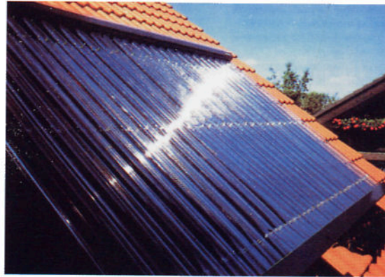
fig. 3-12 Collecteurs plats installés sur une toiture inclinée
