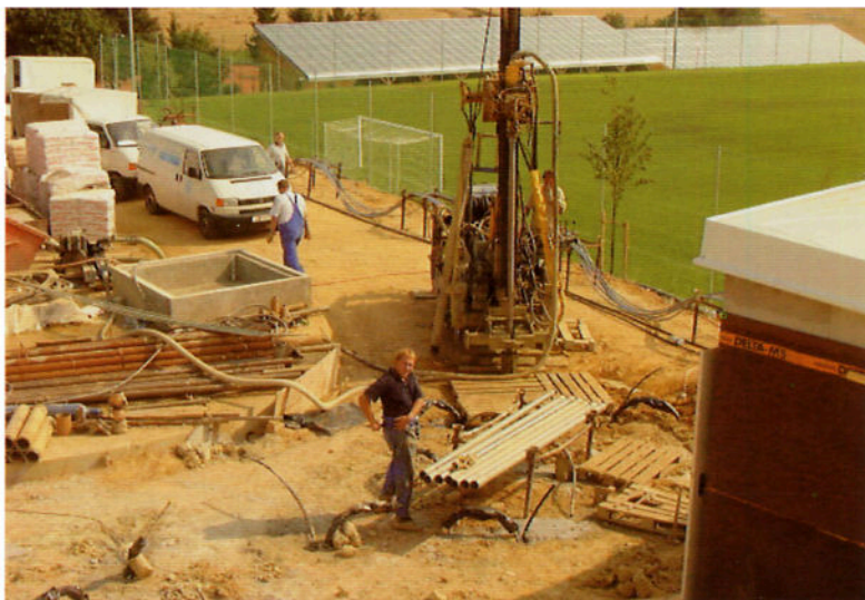
fig. 3-19 Forage d'un collecteur vertical
