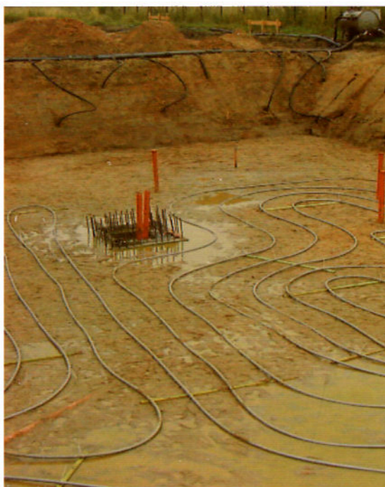
fig. 3-18 Un collecteur de chaleur souterraine enfoui horizontalement
